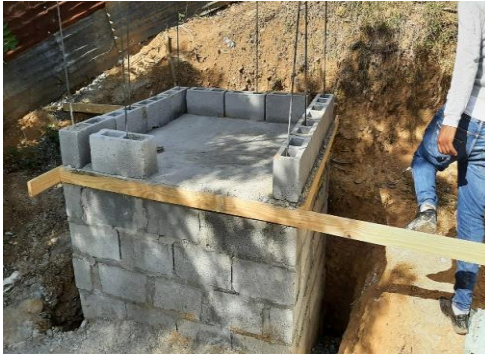
Fundering wordt gelegd
