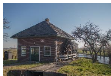
Dieselgemaal Over- en Neder-Slingeland
