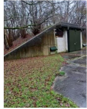
Een van de bunkers
