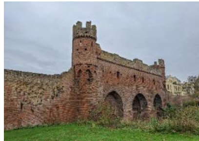
Stadsmuur langs de Berkel
