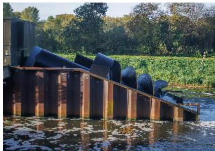
De vijzelconstructie van de centrale
